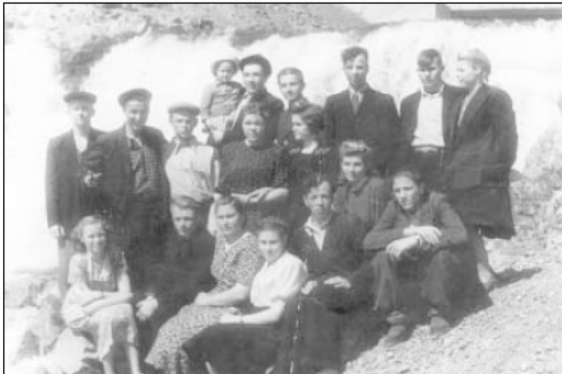
2 смена участка декомпозиции глиноземного цеха БАЗа на плотине
